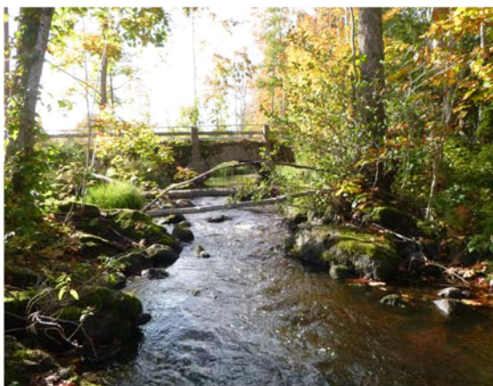
Norra fåran, 10-20m nedströms bron
