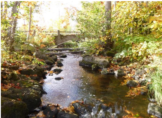
Norra fåran, 10-20m nedströms bron
